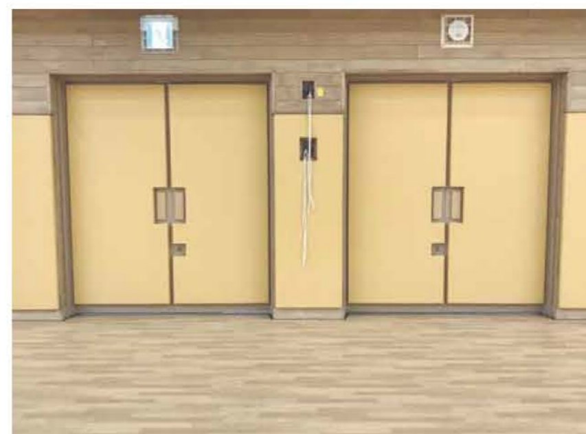
ラテリア NF 【表】不燃シート 難燃ウレタンフォーム 40mm 合板 9mm
