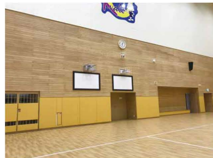
ラテリア NF 【表】不燃シート 難燃ウレタンフォーム 40mm 合板 9mm
