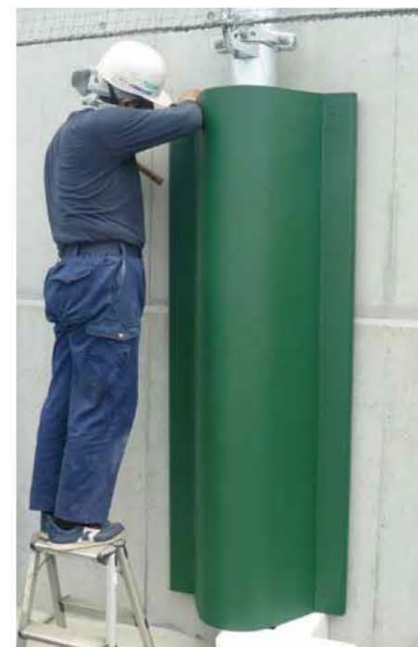
糸魚川市内某小学校
