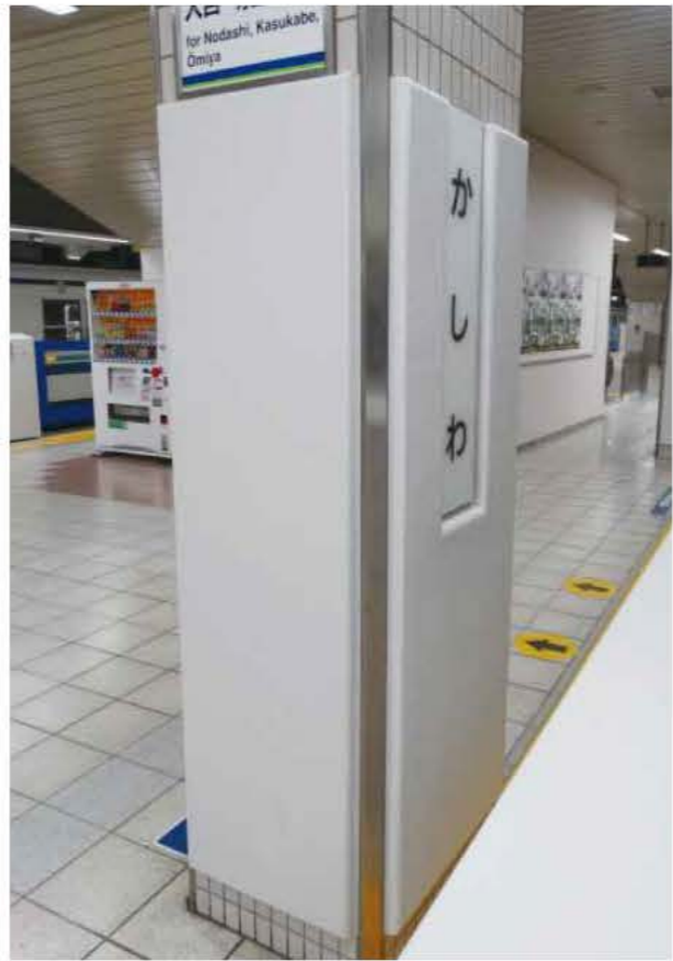
ラテリア PU 【表】ウレタン吹付樹脂 2.0t ウレタンフォーム 30mm 【裏】ウレタン吹付樹脂 1.0t
