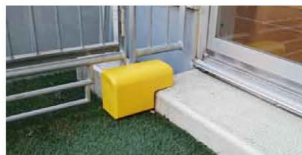
東京都立某高校屋上
